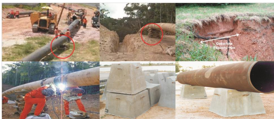
Figura 4: Imagens de intervenções em dutos terrestres e de poitas de concreto pesadas para suportaç o em v o livres de dutos submarinos. Fonte: Elaborado pelos autores.
