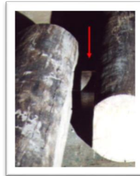
Figura 8: Peças Unidas por Anel Metálico. Fonte: Teribele (2011).
