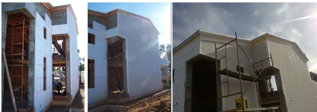
Figuras 16, 17 e 18: Isolamento e Reboco Exterior. Fonte: AlmaVerde.
