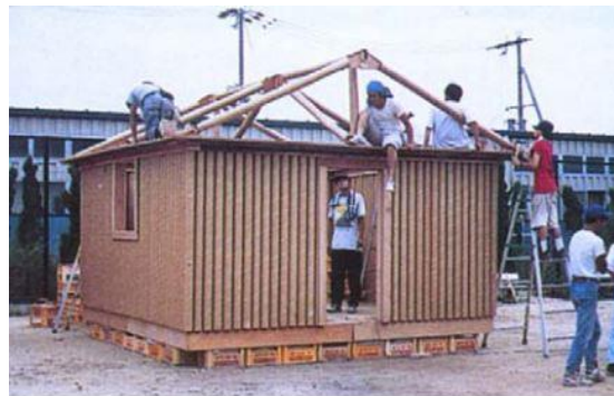
Figura 1 – “Log House” em construção, por voluntários, e vista externa durante sua construção. Fonte: The Japan Architect, summer 1998, p.89.
