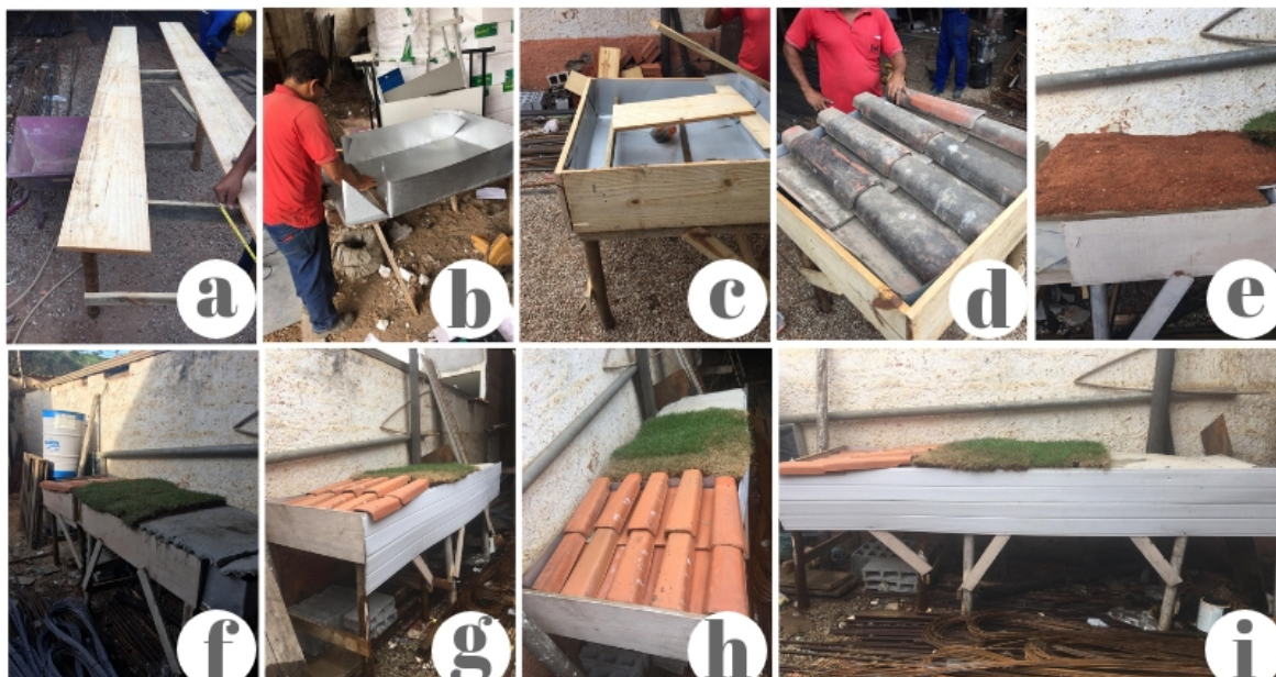
Figura 2 - Etapas para a construção do protótipo de telhados. Fonte: elaborado pelos autores.
