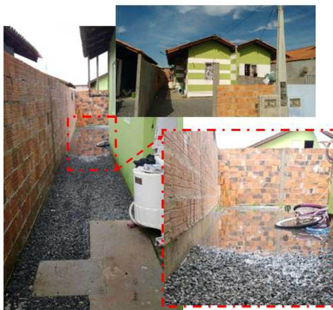
Imagem 8 – Formação da bacia de detenção (fotos do beneficiário – transferidas ao autor)
