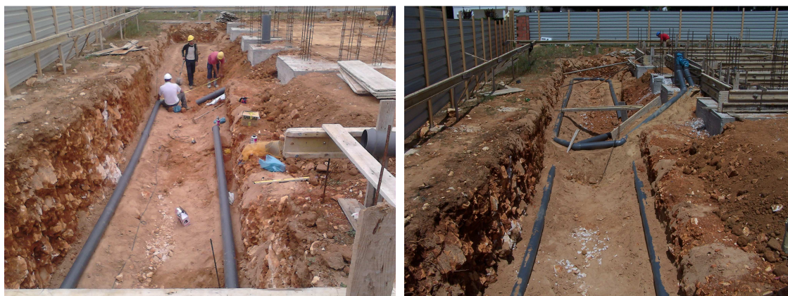
Figuras 3 e 4: Tubos da Coolhouse. Fonte: AlmaVerde.
