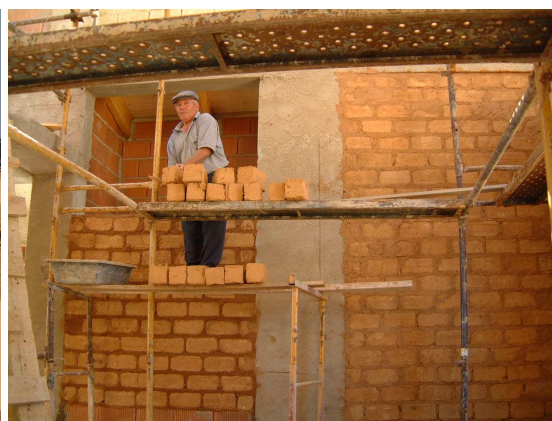
Figura 5: Fabrico de Adobe. Fonte: AlmaVerde. Figura 6: Colocação de Adobe. Fonte: AlmaVerde.
