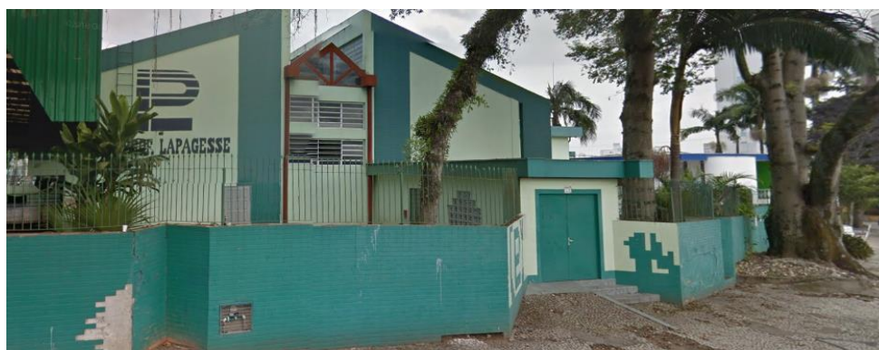
Figura 2: Situação de conservação da escola. Fonte: Carvalho, Rommel e Silva (2017).
