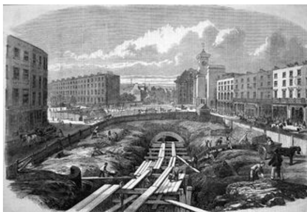
Figura 2: Estágios iniciais de construção da Ferrovia Metropolitana de Londres em 1861. Fonte: wikicommons apud Pereira.
