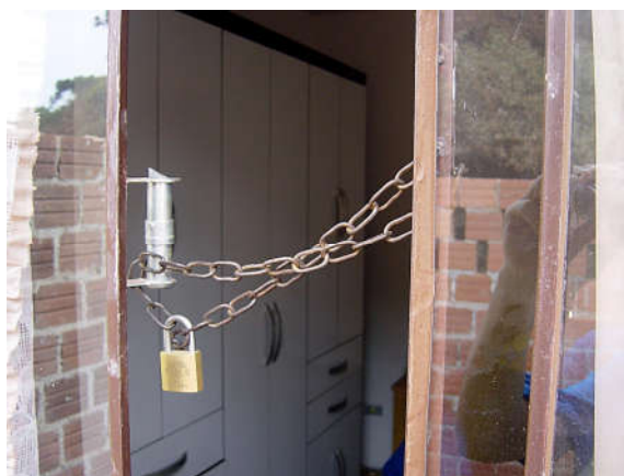
Figura 2: Limitador de abertura da janela. Fonte autores.
