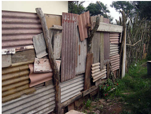
Figura 1 - Muro de divisão. Fonte: elaborada pelos autores.
