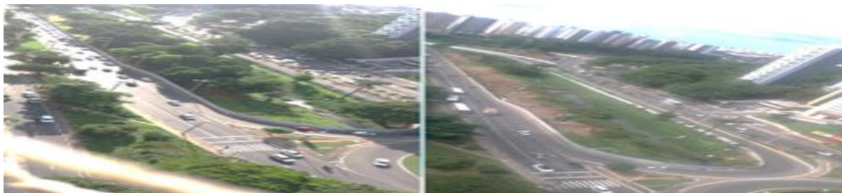
Figura 2: Rio Lucaia nas imediações da Avenida ACM (antes e depois) Fonte: MPF/BA (2018).
