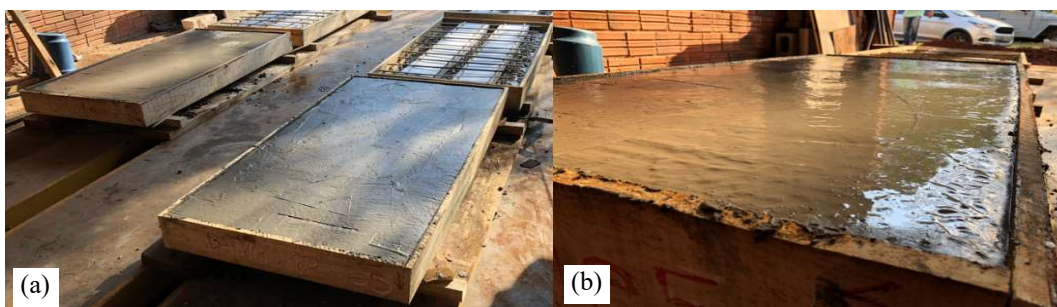
Figura 7a: Lajes recém concretadas (1ª etapa); Figura 7b: Detalhe do nivelamento do concreto.
