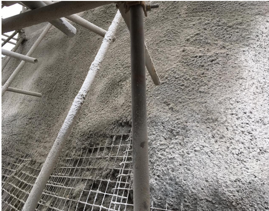
Figura 9: Execução do projetado. Fonte: elaborado pelos autores.
