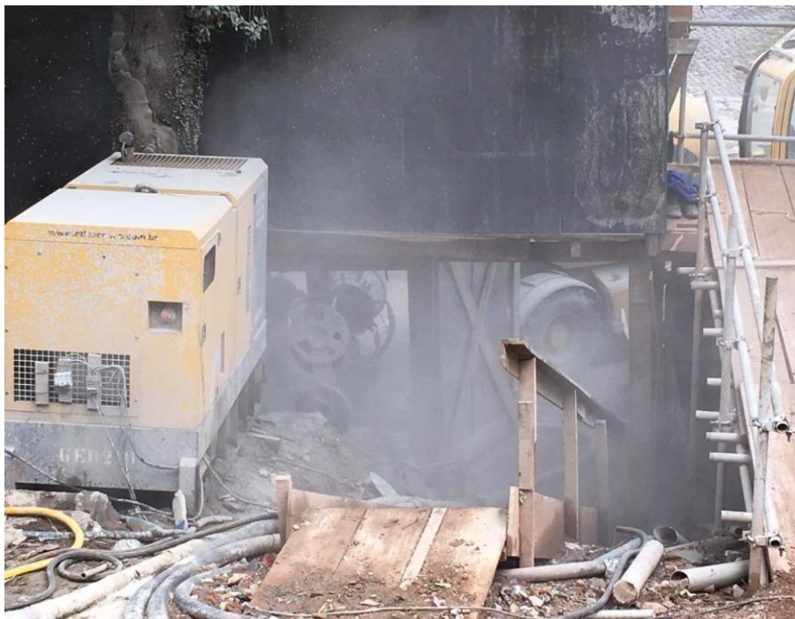
Figura 4: Levantamento de poeira devido a mistura seca. Fonte: elaborado pelos autores.
