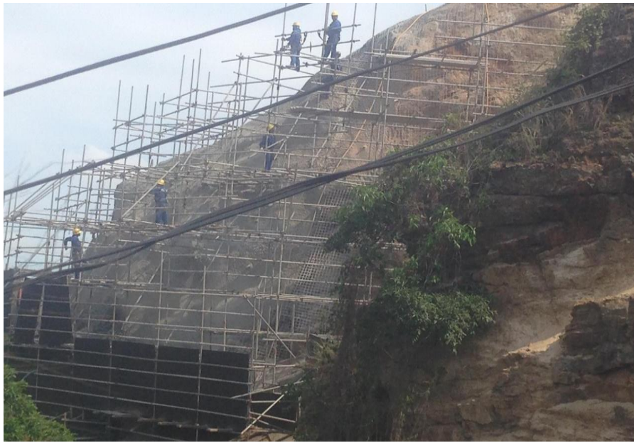
Figura 2: Encosta onde o concreto projetado por via seca será aplicado. Fonte: elaborado pelos autores.
