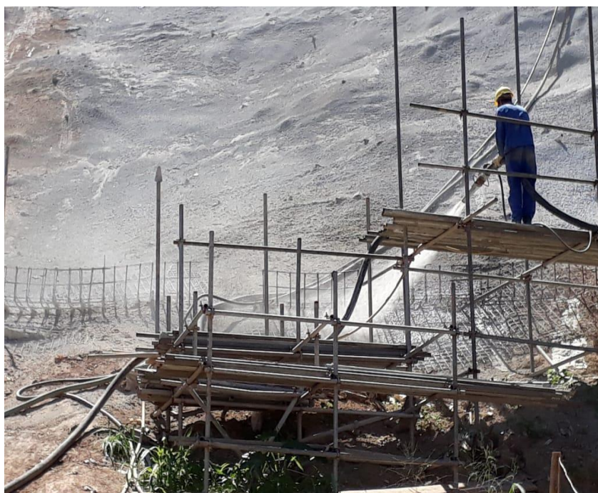
Figura 3: Concreto sendo projetado. Fonte: elaborado pelos autores.
