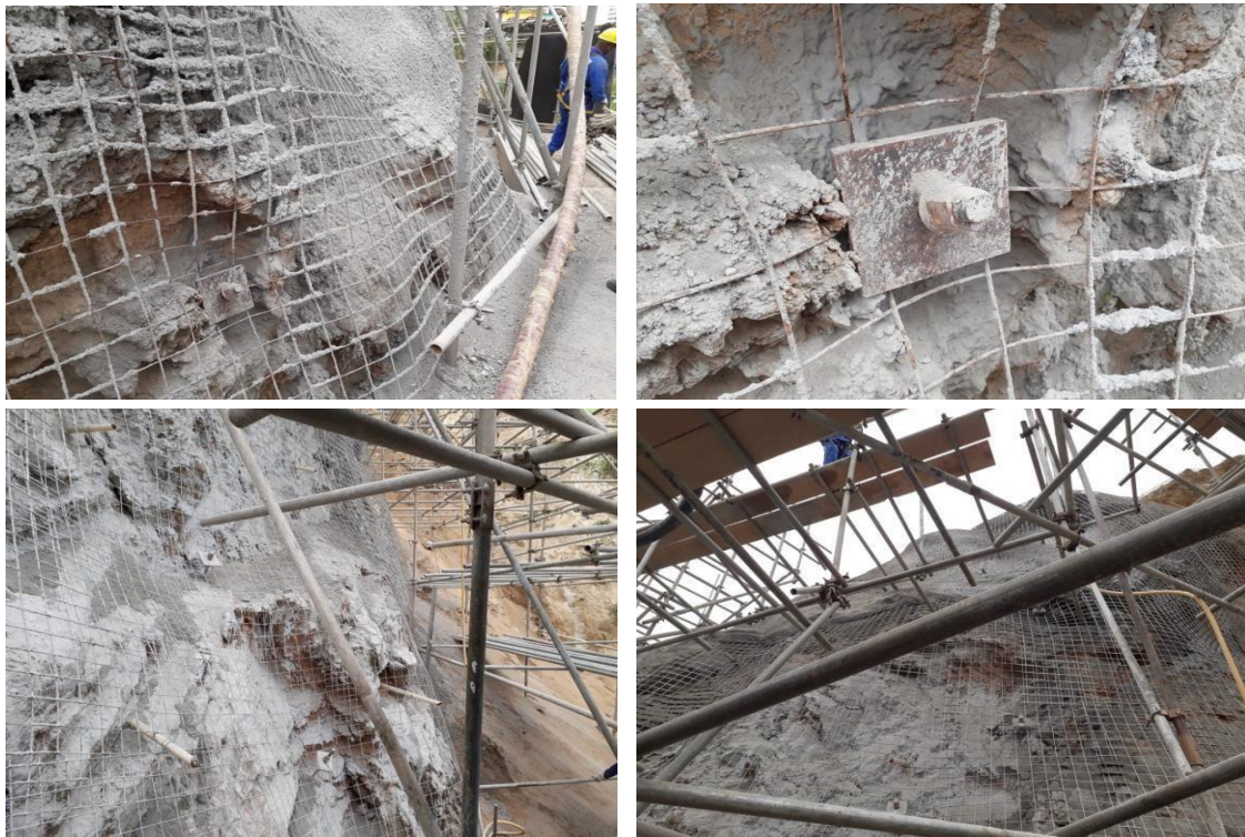
Figura 11: Pontos de concretagem com espessuras superiores a de projeto. Fonte: elaborado pelos autores.
