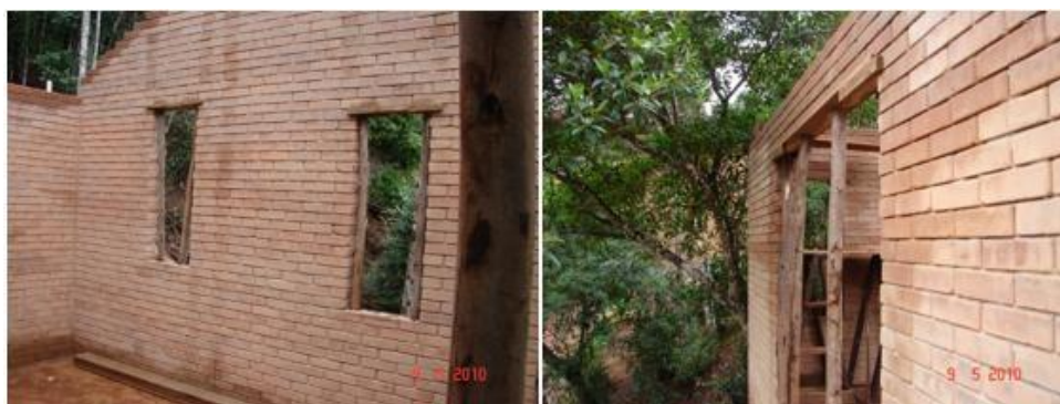
Figura 4: Vergas da porta e janelas. Fonte: Autores.
