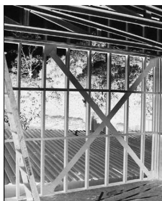
Figura 1: Painel com contraventamento em "X". Fonte: Santiago, et al. 2012.
