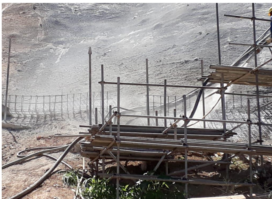
Figura 10: Relexão ocorrendo durante a execução do projetado. Fonte: elaborado pelos autores.
