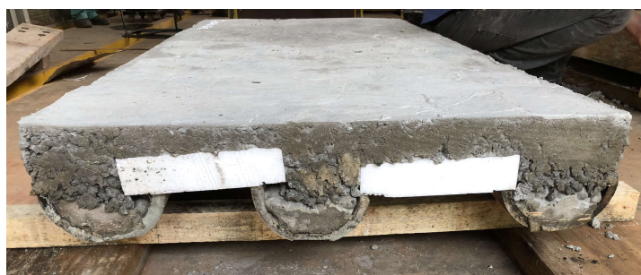
Figura 8: Aspecto final da laje após desforma. Fonte: elaborado pelos autores.
