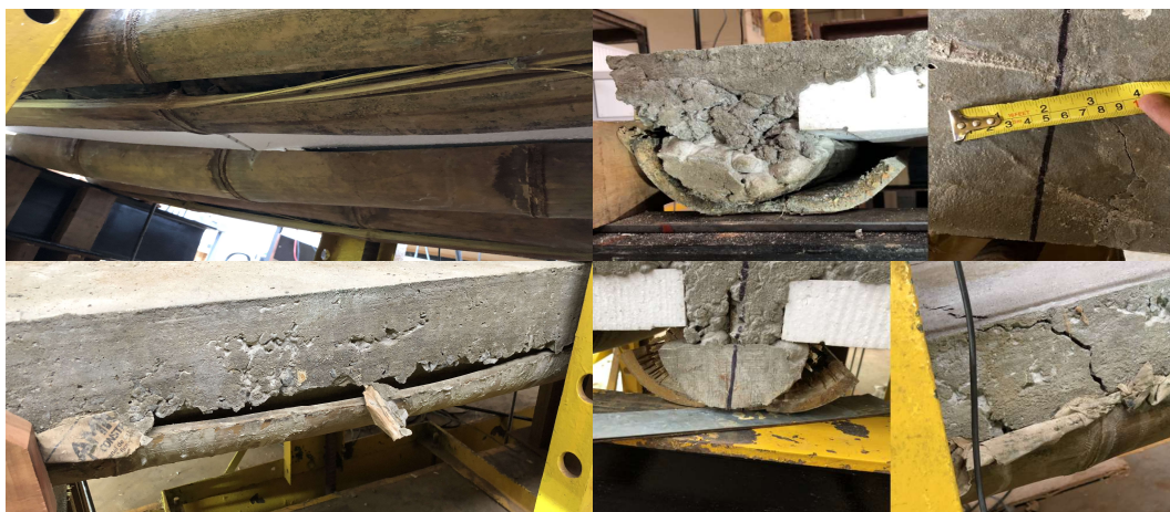
Figura 1: Mecanismos de rupturas das lajes (falha na aderência entre os colmos de bambu e o concreto). Fonte: elaborado pelos autores.
