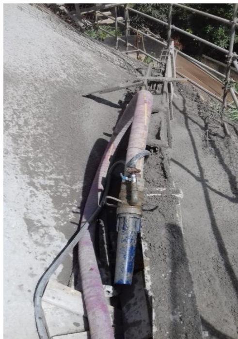
Figura 1: Bico de projeção, local onde a mistura do cimento com os agregados, mistura com a água.
